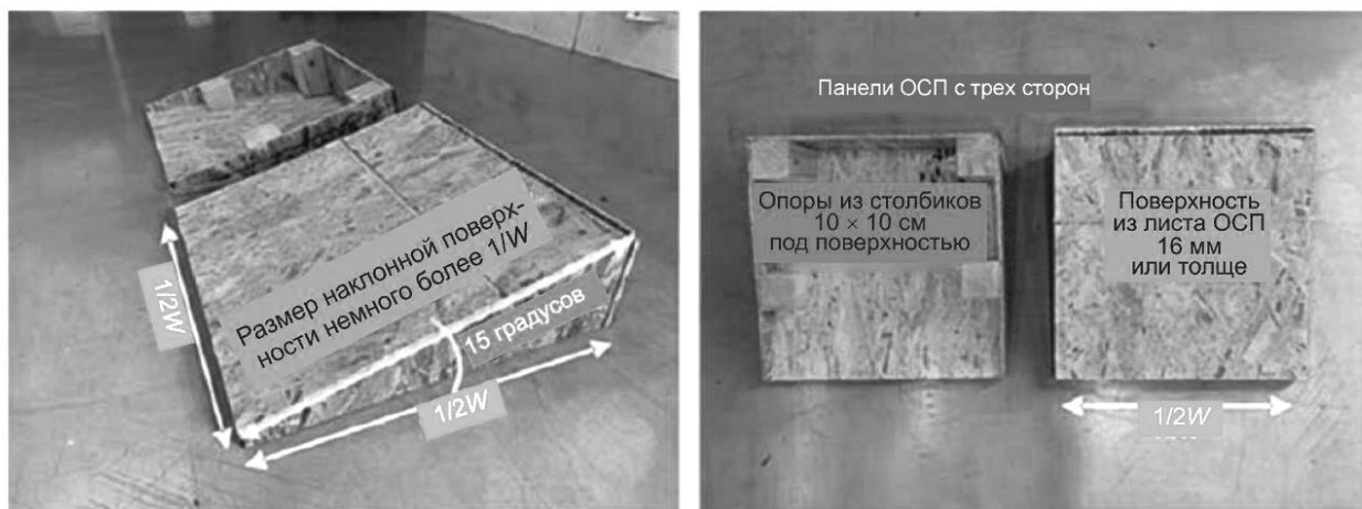
Рисунок 6 — Детали элемента наклонной поверхности
