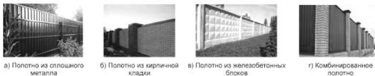
Рисунок 7 — Примеры полотна для обеспечения непросматриваемости
